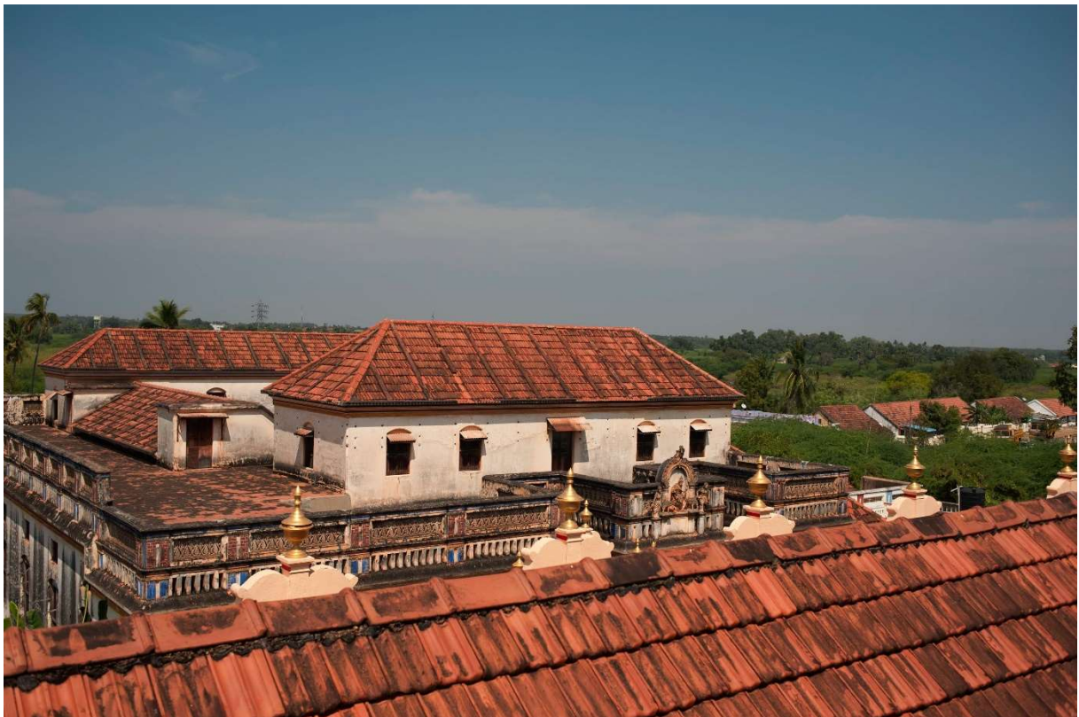
Vue sur une maison palatiale depuis le toit-terrasse d'une autre maison palatiale, la CVCT House, ouverte à la visite, à Kanadukathan. © Émilie Thièse
